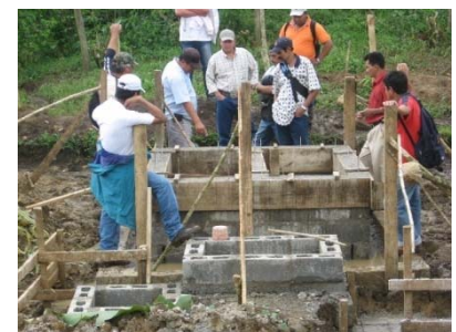
Construcción de instalaciones de beneficio del café durante el proyecto
