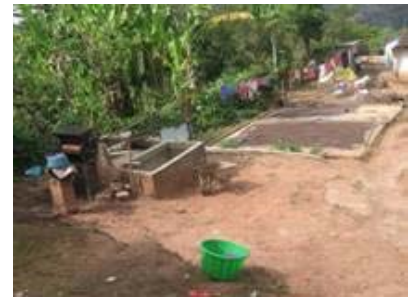
Instalación de beneficio del café destruida y patio de secado al sol antes del proyecto
